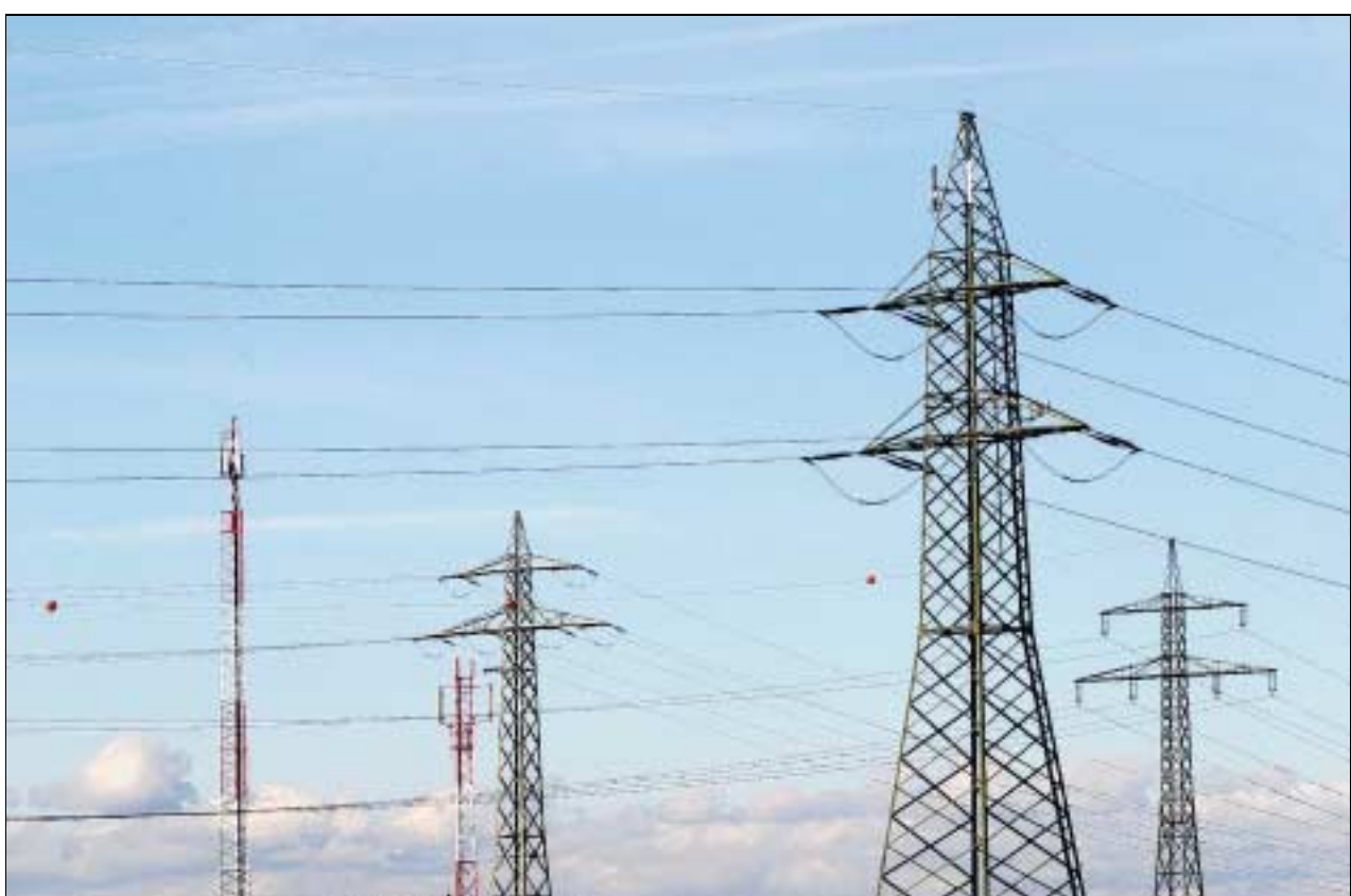
«Stromstrasse» in Österreich aus Hochspannungs-Freileitungen in Kombination mit Mobilfunksendern.
